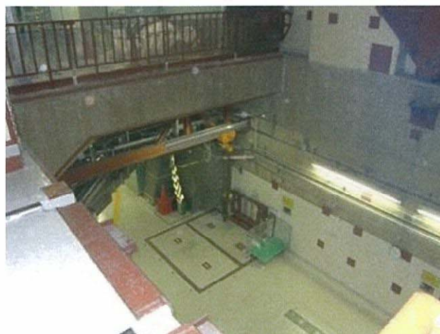
1階から2階機器ハッチ開口状況
