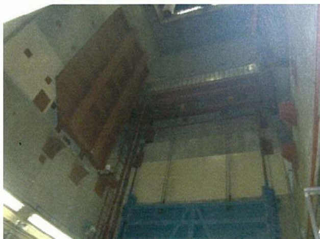
1階機器ハッチ開口状況
