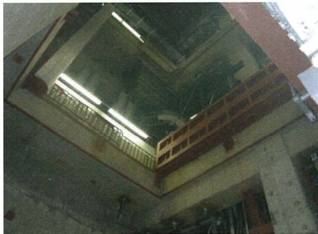
3階から4階機器ハッチ開口状況
