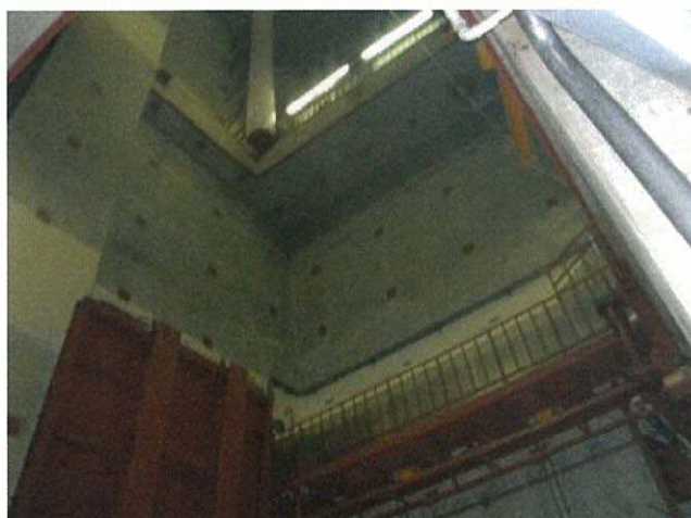
2階から3階機器ハッチ開口状況
