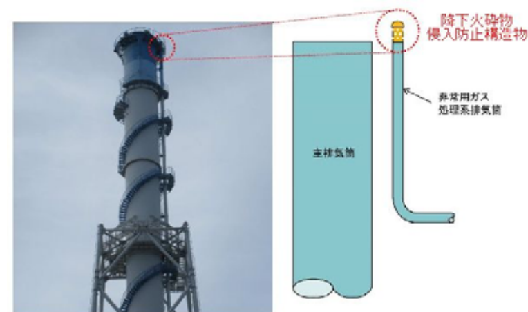
非常用ガス処理系排気管への侵入防止対策
