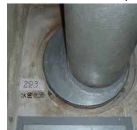
貫通部の止水処置(例)
