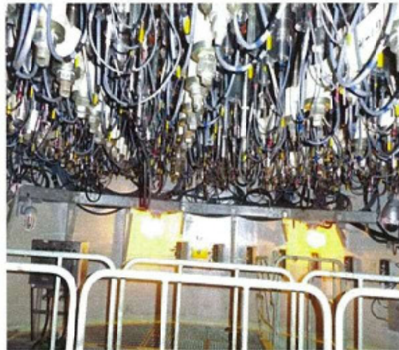
原子炉圧力容器底部の核計装ケーブルの状況
