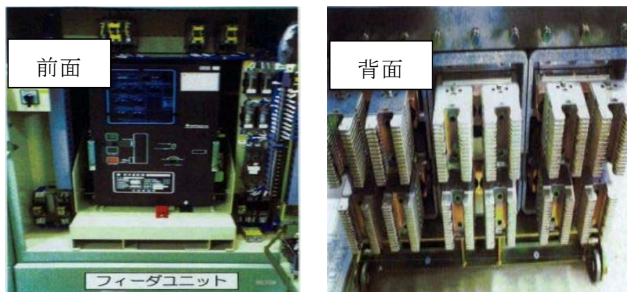
第1-14図 気中遮断器外観
