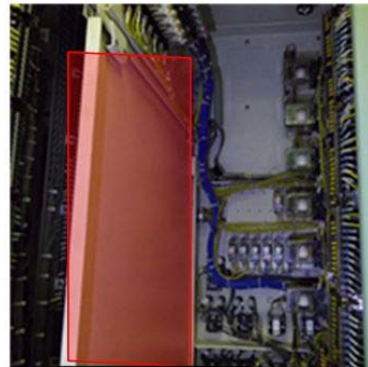
厚さ 3.2mm の金属バリアと 3cm 以上の離隔距離の例
