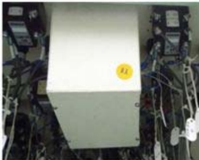
厚さ 1.6mm の金属製筐体の例
