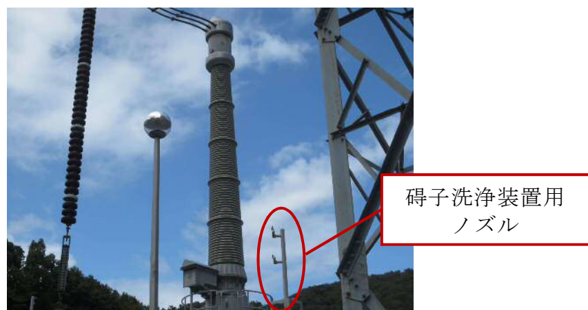
第 2.2.4.6-1 図 碍子洗浄装置外観（イメージ図）
