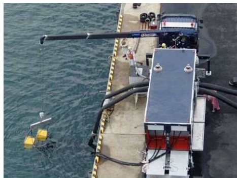
水中ポンプの設置状況
