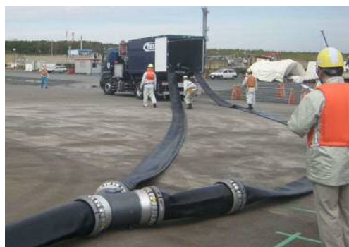
ホースの敷設状況
