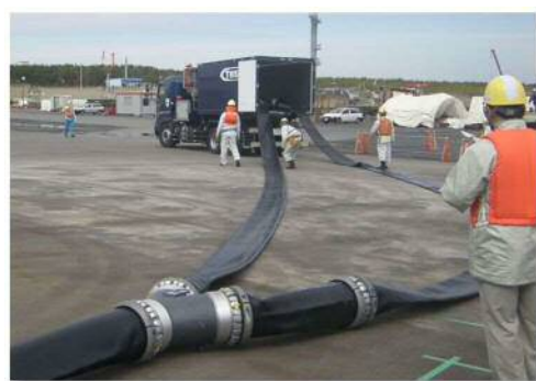
東海港での送水訓練 (ホース敷設)
