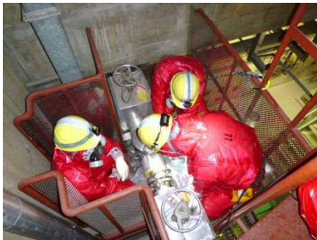
連絡配管閉止フランジ切替訓練
