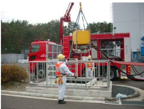
放射線防護具装着による送水訓練 （水中ポンプユニット設置）
