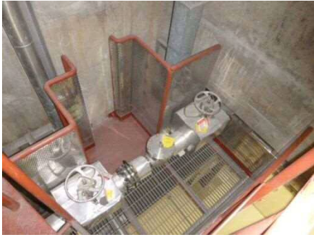
作業場所（全体）
