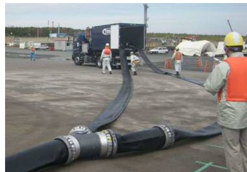
東海港での送水訓練 (ホース敷設)
