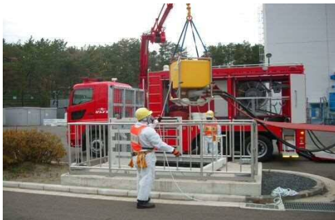
放射線防護具装着による送水訓練 （水中ポンプユニット設置）
