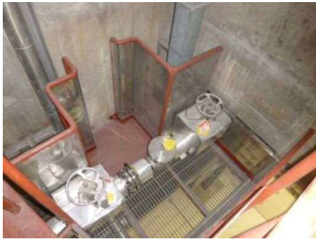
作業場所（全体）
