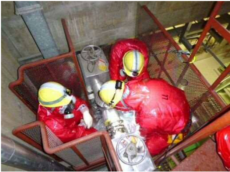
連絡配管閉止フランジ切替訓練
