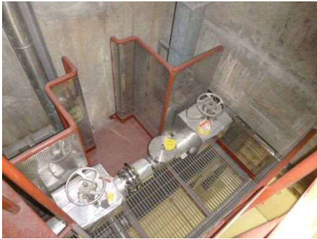
作業場所（全体）
