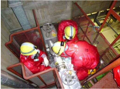
連絡配管閉止フランジ切替訓練
