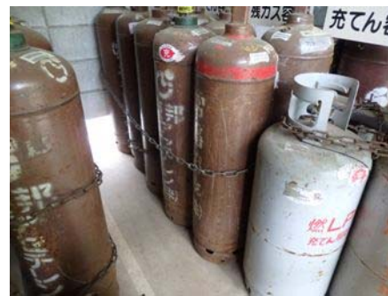
協力会社ボンベ小屋 アセチレン・プロパンボンベ設置状況
