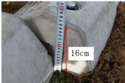
【段差復旧検証用段差】
