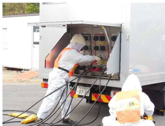
第 1.0.13-3 図 放射線防護具類を着用した状態での作業状況
