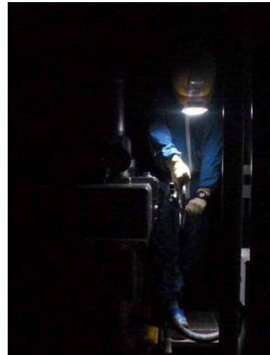
(可搬型照明を使用した 状態での作業)
