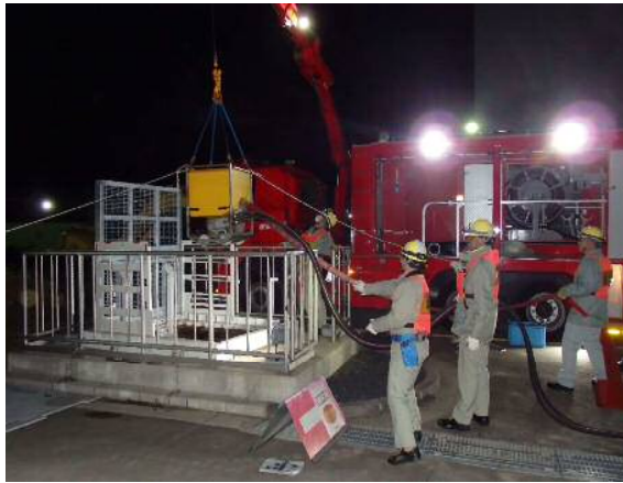
(暗所環境下での作業状況の例)
