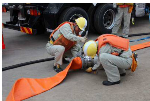
可搬型代替注水大型ポンプの訓練の状況 （ホースを接続するクランプ部の接続作業）
