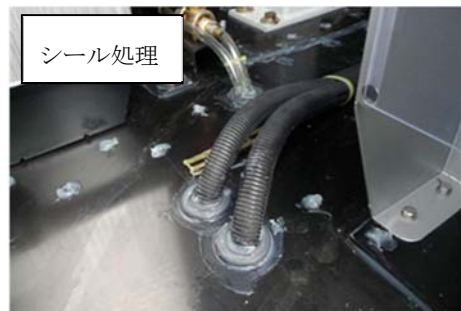
第1図 可搬型設備 小動物対策例 (1/2)
