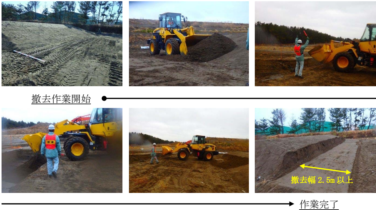
第 8 図 土砂撤去検証の写真
