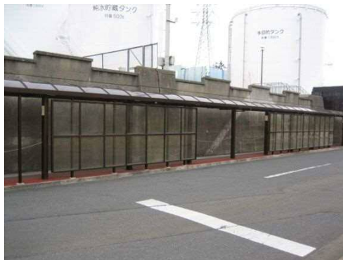
別図 1-12 東海第二発電所における屋外屋根の状況
