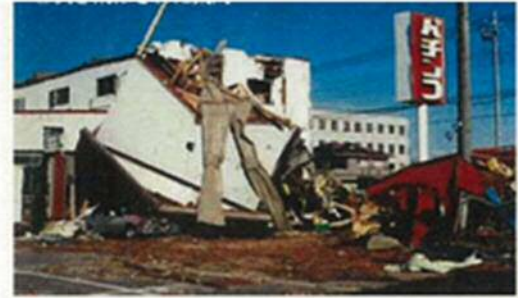
吹き飛ばされた建物
