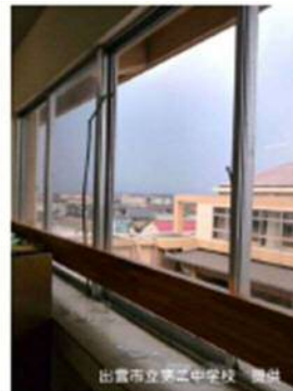
屋外に面した窓ガラス
