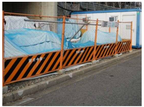
#343 仮囲い板，仮設フェンス
