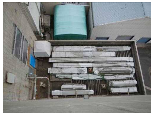
#301 足場板, 足場枠
