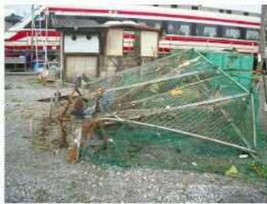
フェンスの著しい変形
