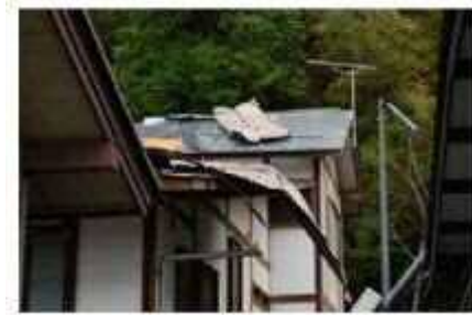
飛来物（鋼板製屋根材）の衝突
