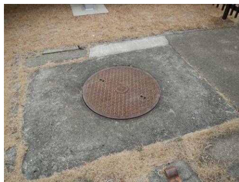
#246 マンホール蓋
