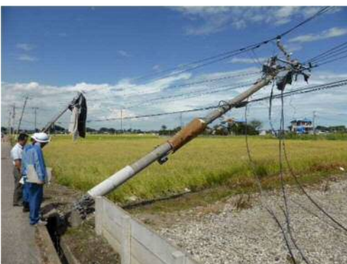
電柱の倒壊
