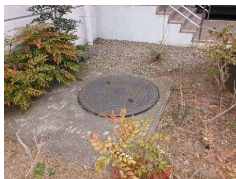
#49 マンホール蓋
