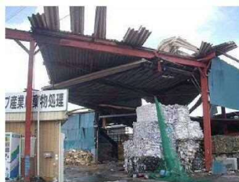
折板の損傷
