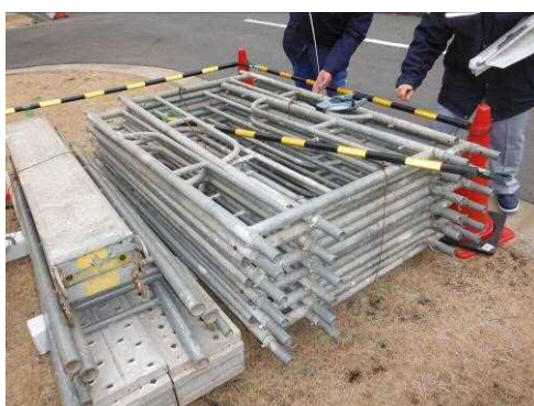
#38 足場板, 足場枠
