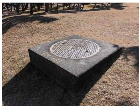
#186 マンホール蓋
