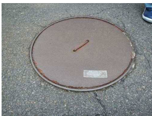
#316 マンホール蓋
