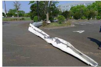
飛散した鋼板製屋根材
