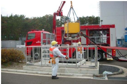
放射線防護具着用による送水訓練 （水中ポンプユニット設置）
