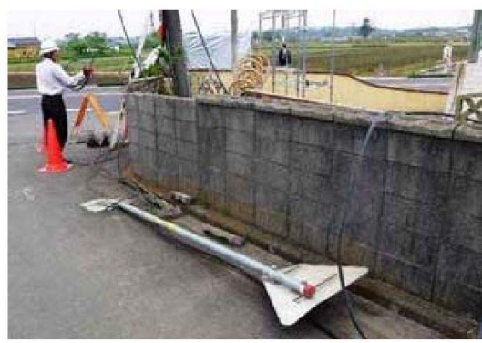
道路標識の倒壊
