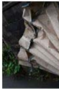
飛散した折板屋根の損傷状況
