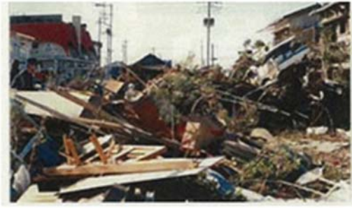
残骸(飛散物)で埋め尽された道路
