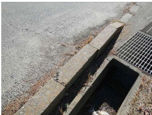
#417 コンクリート製ブロック
