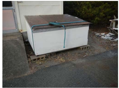
#350 鋼製ボックス
