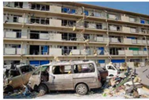
飛来物により被害を受けた住宅等
