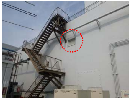
図2 外気取入口（中央制御室換気空調系）
