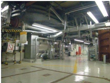
通路上の機器設置状況
