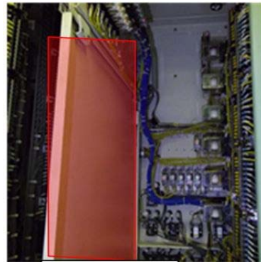
金属製バリア：厚さ 3.2mm 以上 (約 4mm) 離隔距離 : 3cm 以上 (約 3cm 以上)
