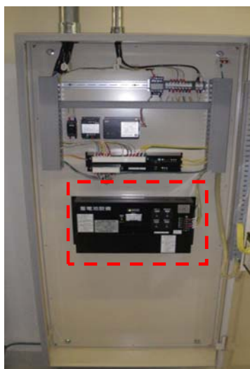
第1-31図 二酸化炭素自動消火設備（全域）制御盤内蓄電池
