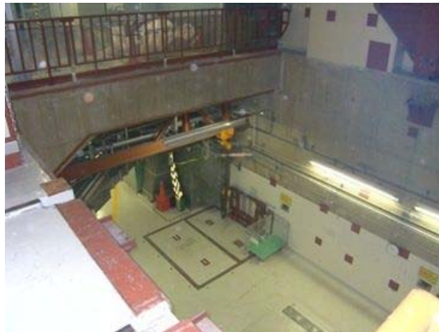
1階から2階機器ハッチ開口状況
