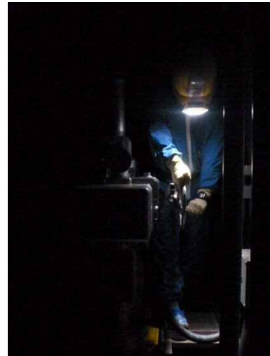
(可搬型照明を使用した 状態での作業)
