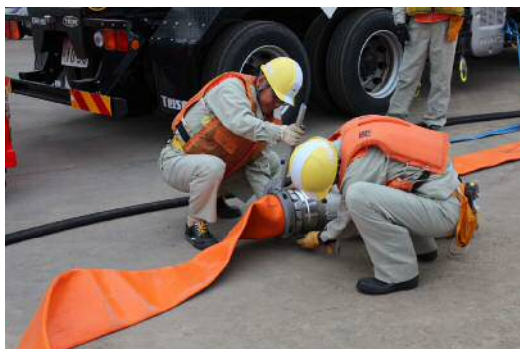
可搬型代替注水大型ポンプの訓練の状況 （ホースを接続するクランプ部の接続作業）
