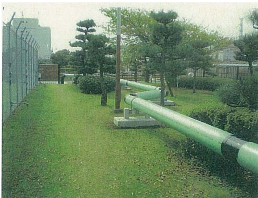
第 3 図 屋外消火配管の地上化
