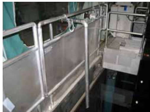
使用済燃料プール周り（手摺り）
