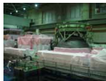
原子炉建屋原子炉棟 6階東側
