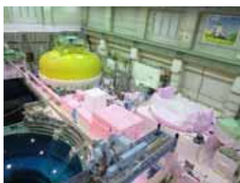
原子炉建屋原子炉棟 6階西側
