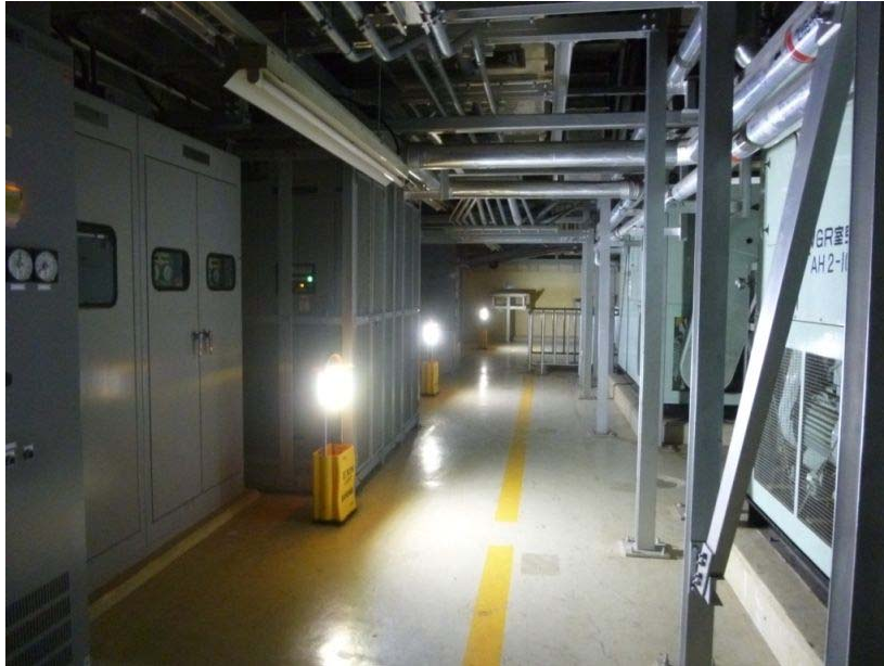
第 3.3-8 図 チェンジングエリア設置場所における 可搬型照明（S A）確認状況
