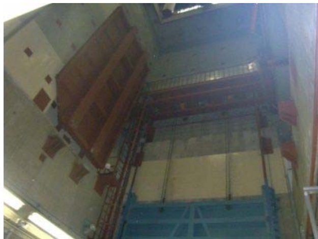
1階機器ハッチ開口状況
