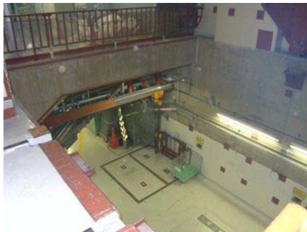
1階から2階機器ハッチ開口状況
