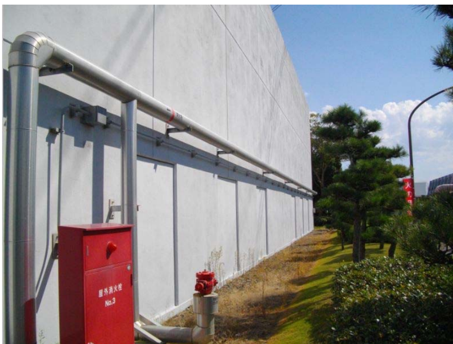
第1-36図 屋外消火配管への保温材設置状況
