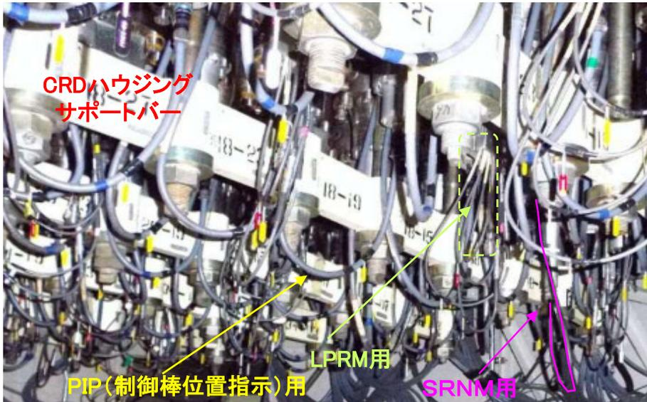
原子炉圧力容器底部(ペDESTAL部)の核計装ケーブルの状況
