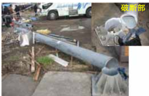
倒壊した道路標識支柱
