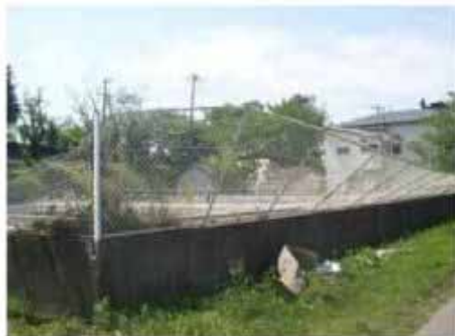
フェンスの変形
