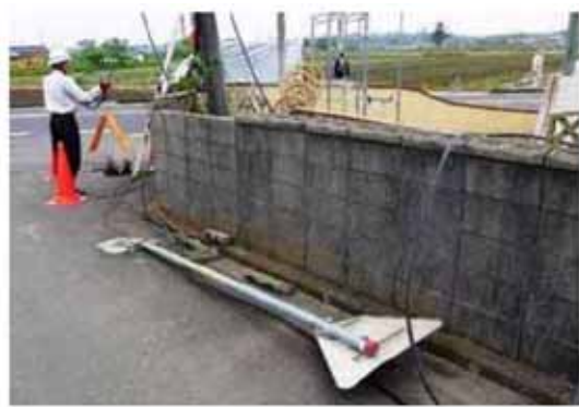
道路標識の倒壊
