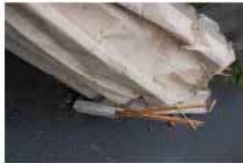
飛散した折板屋根の損傷状況
