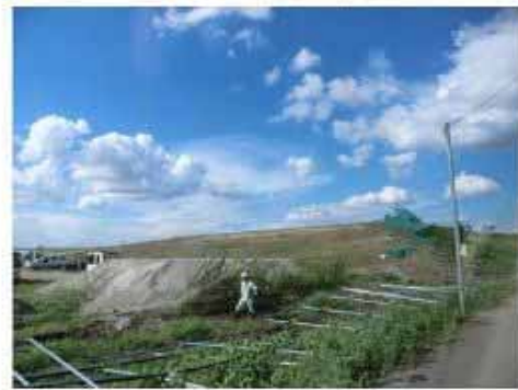
フェンスの倒壊
