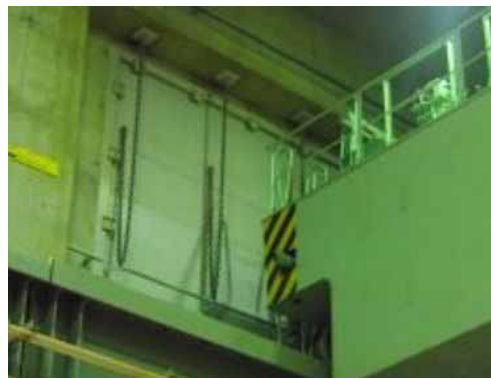
別図 1-32 東海第二発電所における原子炉建屋ブローアウトパネルの 設置状況
