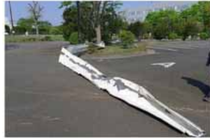
飛散した飛来物（鋼板製屋根材）
