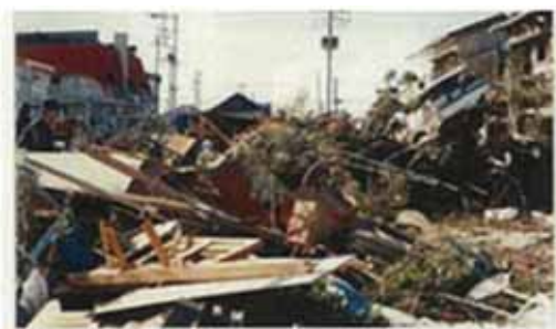
残骸(飛散物)で埋め尽された道路
