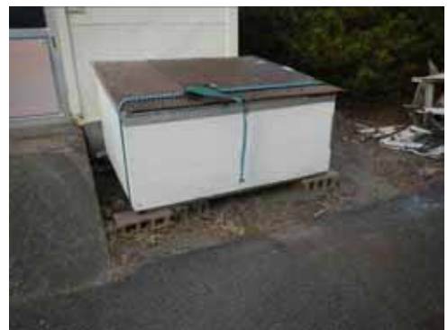
#350 鋼製ボックス
