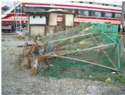
フェンスの著しい変形
