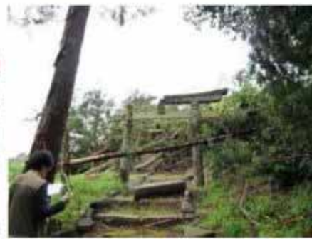
樹木の折損と鳥居の被害
