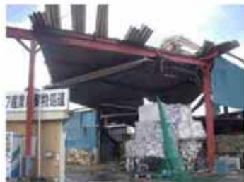
折板の損傷
