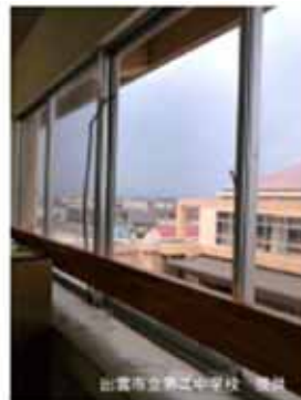
屋外に面した窓ガラス
