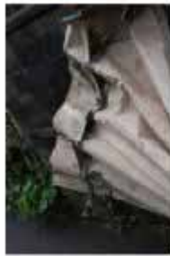
飛散した折板屋根の損傷状況
