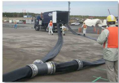
東海港での送水訓練 (ホース敷設)
