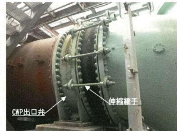
循環水ポンプ出口管及び 伸縮継手(現状)
