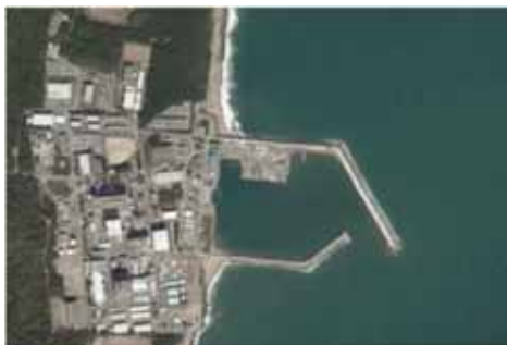
写真 東海第二発電所全景
