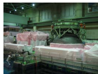
原子炉建屋原子炉棟 6 階東側
