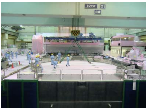
使用済燃料プール周り（全体）
