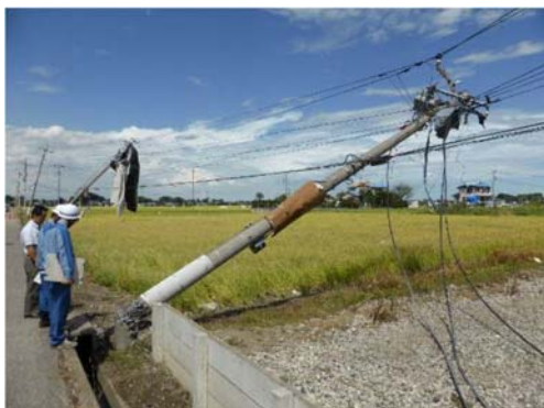
電柱の倒壊
