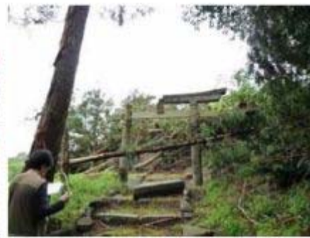
樹木の折損と鳥居の被害
