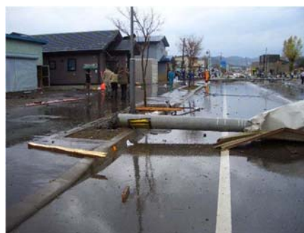
道路側へ倒壊した電柱
