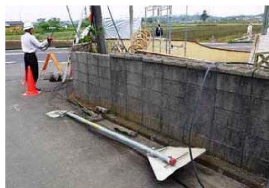
道路標識の倒壊
