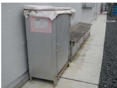
#287, #288 鋼製ボックス
