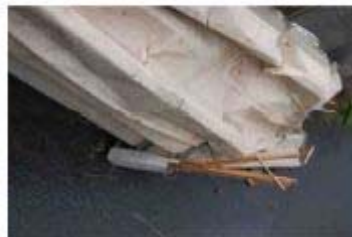
飛散した折板屋根の損傷状況
