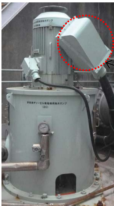
第2.4.2-7図 ディーゼル発電機用海水ポンプ電動機 構造図
