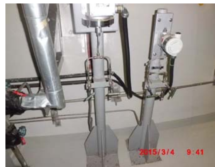
格納容器圧力用伝送器の例
