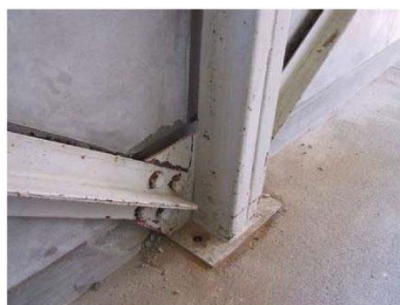
間柱脚部アンカーボルト破断
