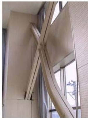
間柱脚部アンカーボルト破断
