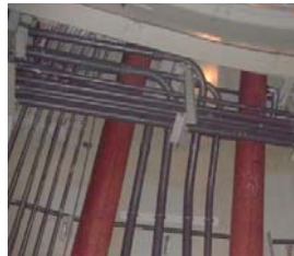
ケーブルは電線管敷設
