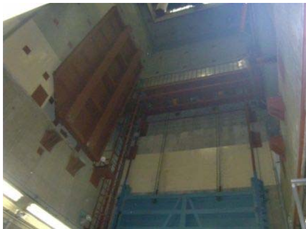
1階機器ハッチ開口状況
