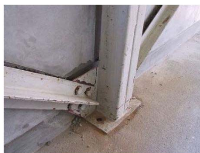
間柱脚部アンカーボルト破断
