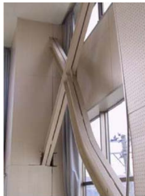
間柱脚部アンカーボルト破断
