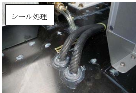
第1図 可搬型設備 小動物対策例 (1/2)
