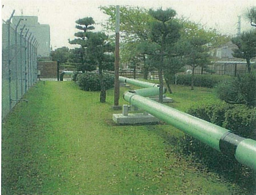
第 3 図 屋外消火配管の地上化
