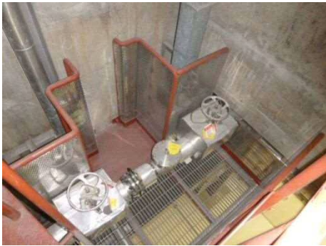
作業場所（全体）
