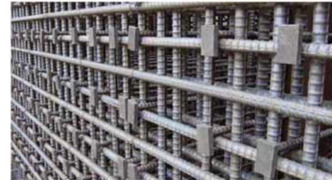
壁部材への適用状況
