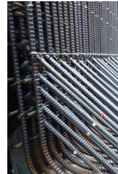
土木地中構造物への適用状況
