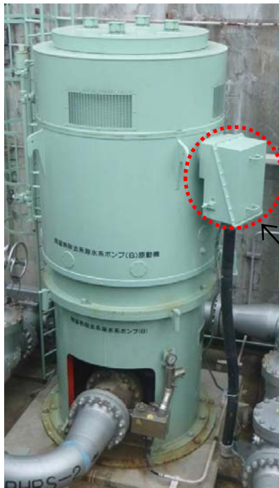
第2.4.2-6図 残留熱除去系海水系ポンプ電動機 構造図
