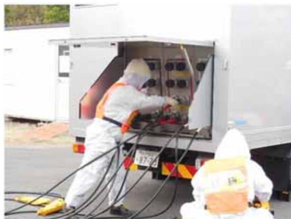
第 1.0.13-3 図 放射線防護具類を着用した状態での作業状況
