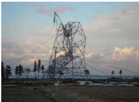
津波による隣接鉄塔の倒壊に伴う送電鉄塔の倒壊事例<sup>※2</sup>
