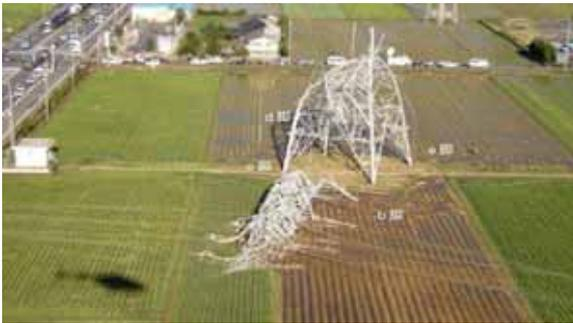
強風による送電鉄塔の倒壊事例①<sup>※1</sup>
