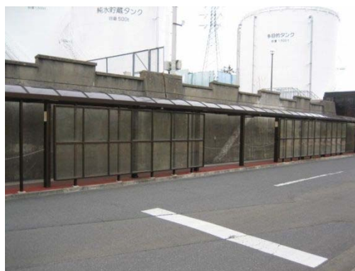
別図 1-12 東海第二発電所における屋外屋根の状況
