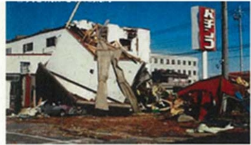
吹き飛ばされた建物
