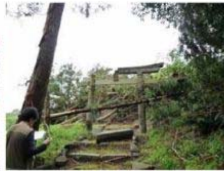
樹木の折損と鳥居の被害
