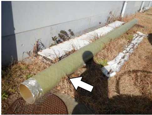
#405 樹脂製パイプ
