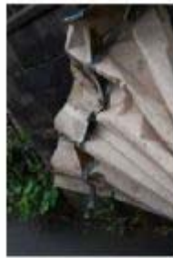
飛散した折板屋根の損傷状況
