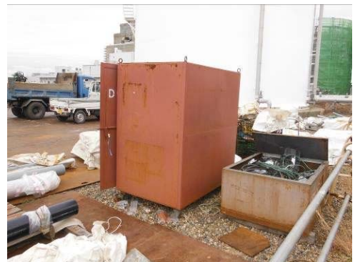
#62 鋼製ボックス
