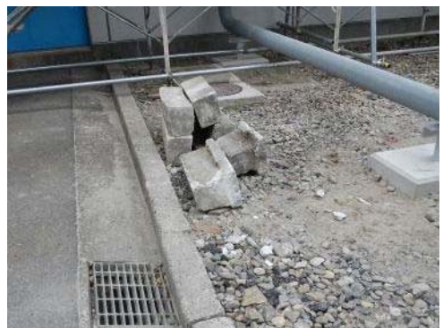
#314 コンクリートブロック
