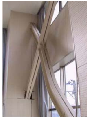
間柱脚部アンカーボルト破断
