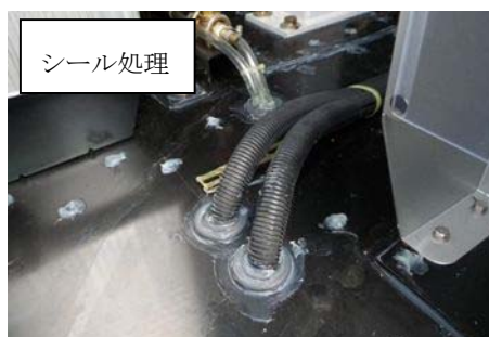
第1図 可搬型設備 小動物対策例 (1/2)
