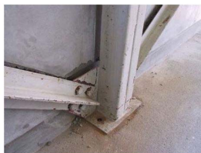
間柱脚部アンカーボルト破断
