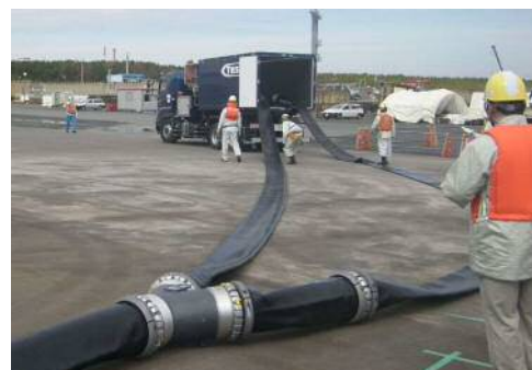
東海港での送水訓練 (ホース敷設)
