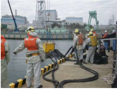
東海港での送水訓練 (水中ポンプユニット設置)
