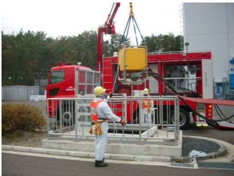
放射線防護具着用による送水訓練 （水中ポンプユニット設置）
