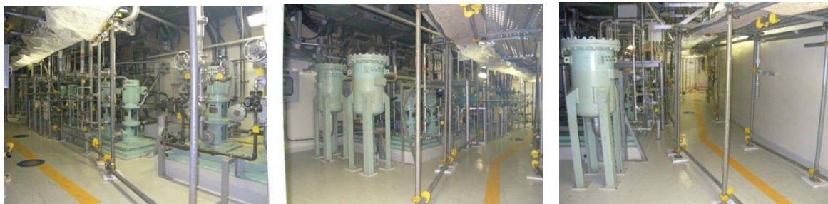
サンプポンプ設置状況
