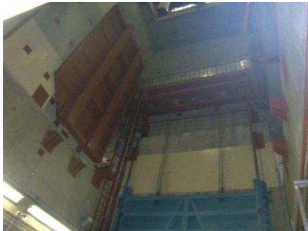
1階機器ハッチ開口状況
