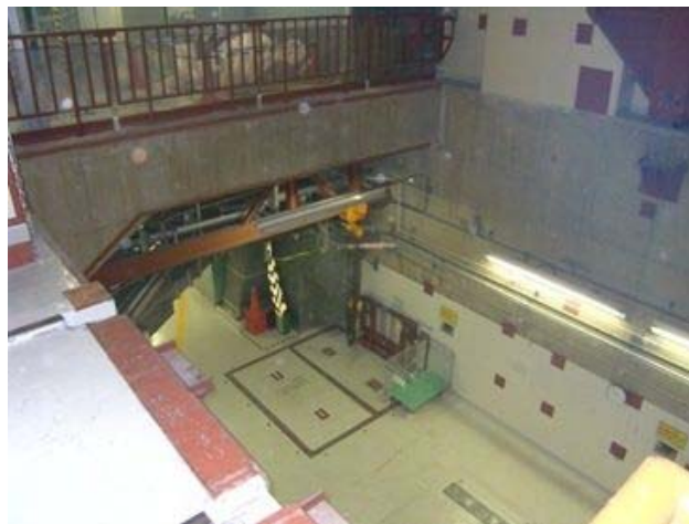
1階から2階機器ハッチ開口状況
