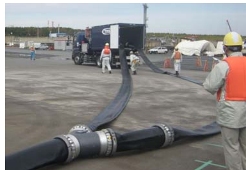
東海港での送水訓練 (ホース敷設)
