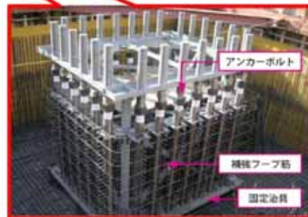
第 1-32 図 基礎定着部の概念図
