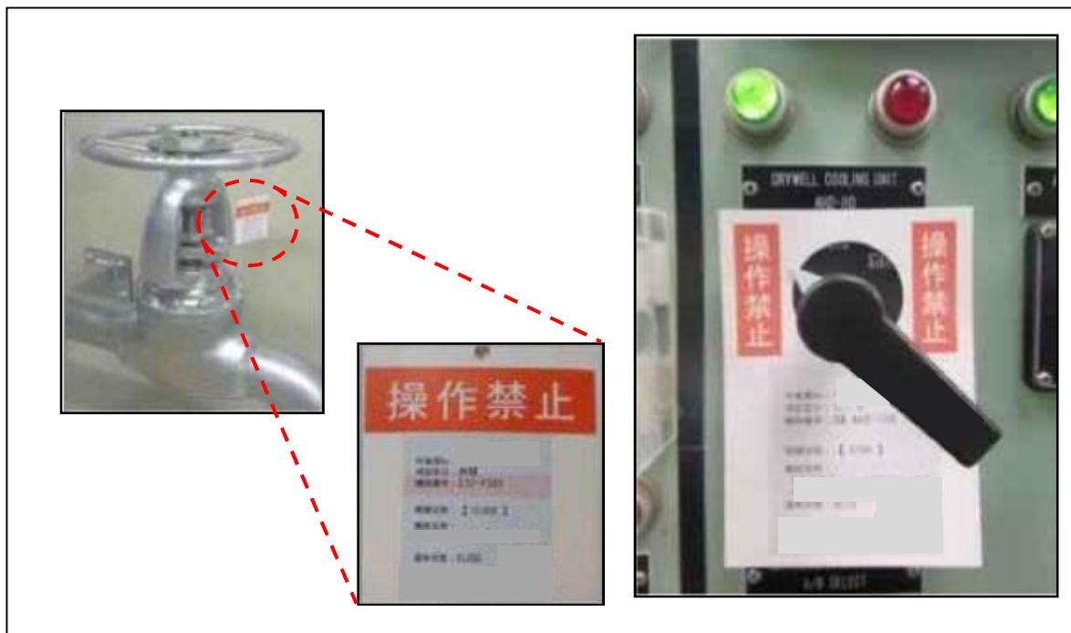
第 2.4.3-1 図 操作禁止札による識別（例）
