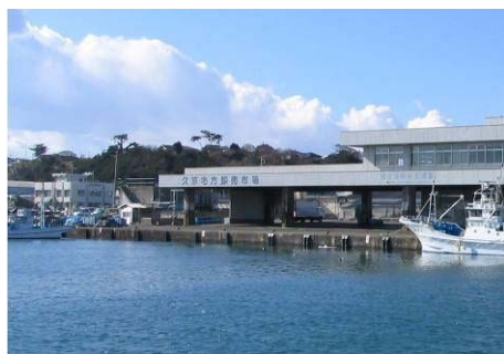
写真③ 久慈漁港状況
