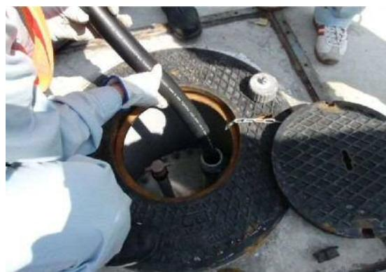
可搬型設備用軽油タンクへのホース挿入
