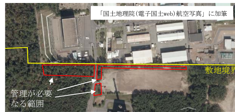
図 発電所南側(範囲B, C)の航空写真
