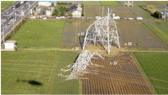
強風による鉄塔の倒壊事例①※ 1
