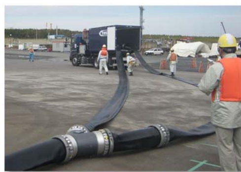
東海港での送水訓練 (ホース敷設)
