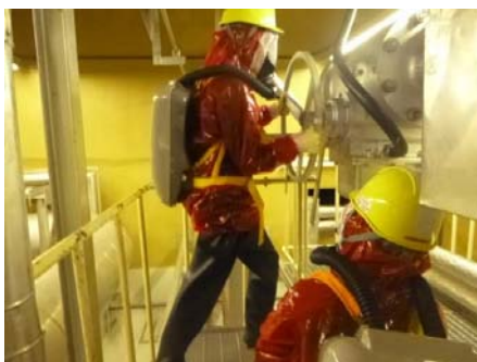
現場手動隔離操作 (放射線防護具着用)
