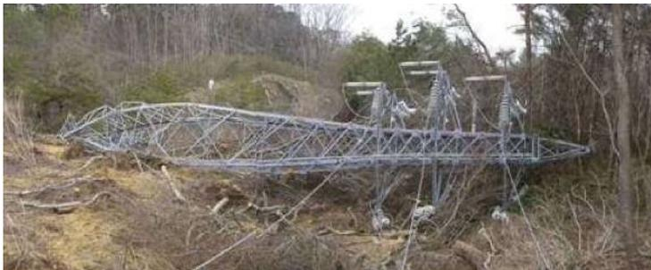
地震による斜面の崩落に伴う送電鉄塔の倒壊事例<sup>※2</sup>
