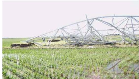
強風による送電鉄塔の倒壊事例②<sup>※1</sup>
