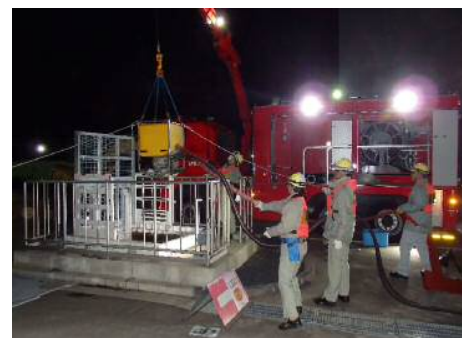
(暗所環境下での 作業状況の例)
