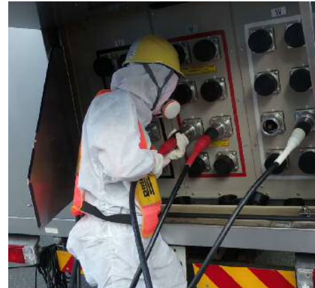
第 1.0.13-4 図 放射線防護具類を着用した状態での電源車のケーブル敷設作業
