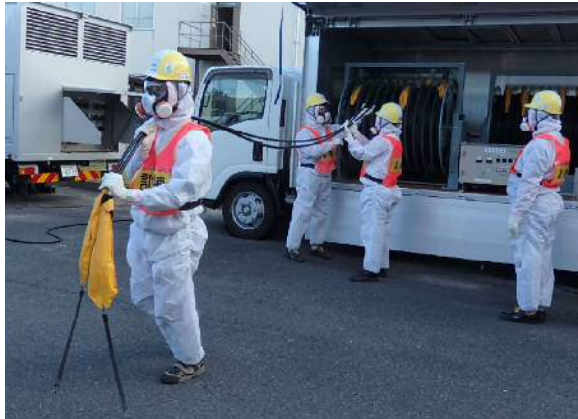
第 1.0.13-4 図 放射線防護具類を着用した状態での電源車のケーブル敷設作業
